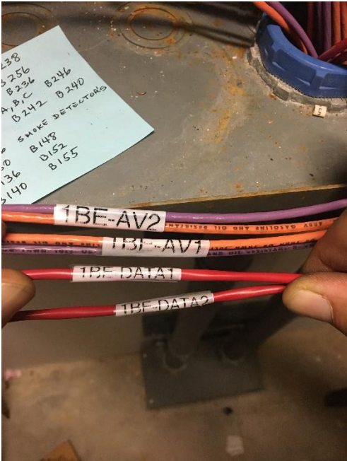
SMOKE DETECTOR CABLES - HORN/STROBE & DOOR CABLES
