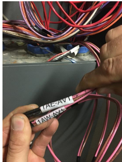
HORN/STROBE & DOOR CABLES
